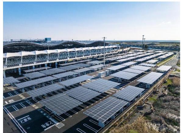
出展「仙台空港再生エネ発電合同会社」
